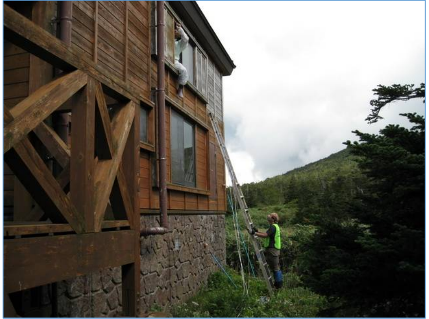
南側 塗装作業中
