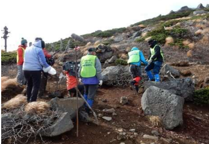
水切り設置作業状況撮影
