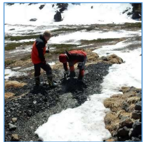
水切り設置作業(お鉢籠)
