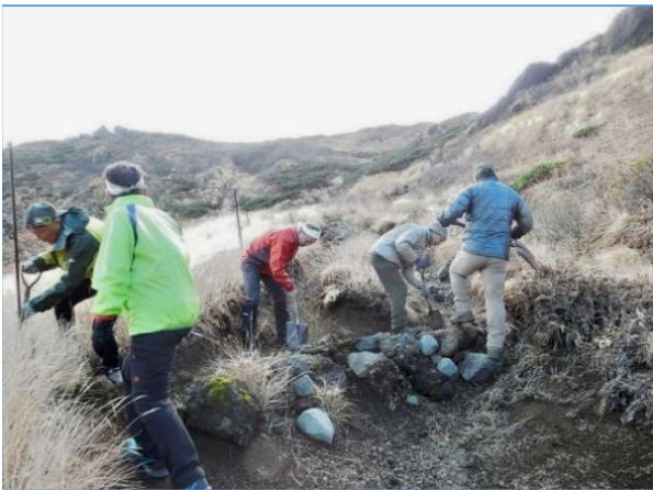
不動平避難小屋前への流れ込みを防止するため、水切り設置と補修作業を実施 (撮影:工藤)
