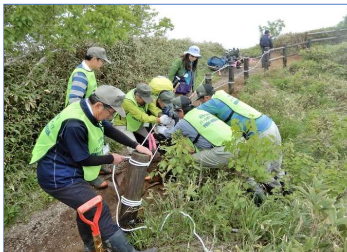
網張元湯展望台木柵補修
