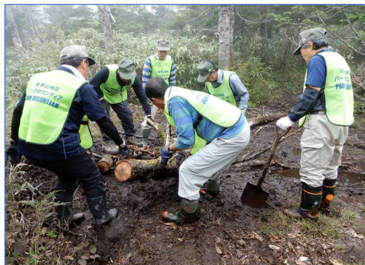
登山道泥濘区間補修 (A地点の水切&風倒木敷設)
