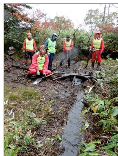
水切り設置完了
