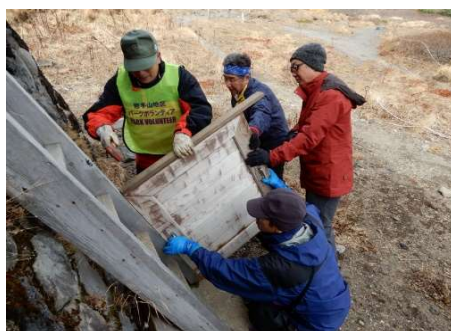
北側冬季出入口覆板が変形してはまらないので、応急修理
