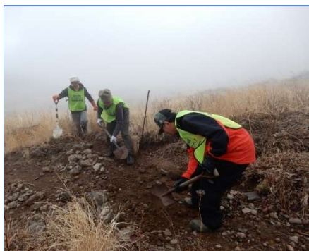
小屋～鬼ヶ城分岐間水切り4か所の補修作業（撮影：浪岡）
