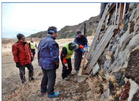
北側冬季出入口覆板が変形してはまらないので、応急修理
