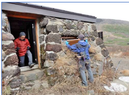
トイレ窓の覆板取り付け
