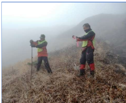
小屋～鬼ヶ城分岐間に積雪・残雪期のルート目印となる鉄筋の保守作業
