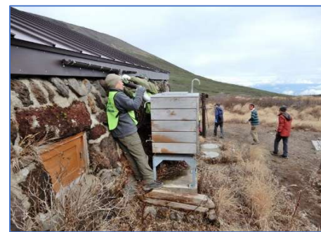
天水溜集水パイプ撤去等
