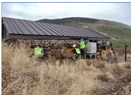
東側窓の覆板取り付け
