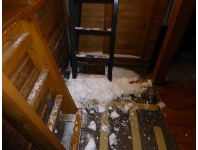
1階の階段部分
