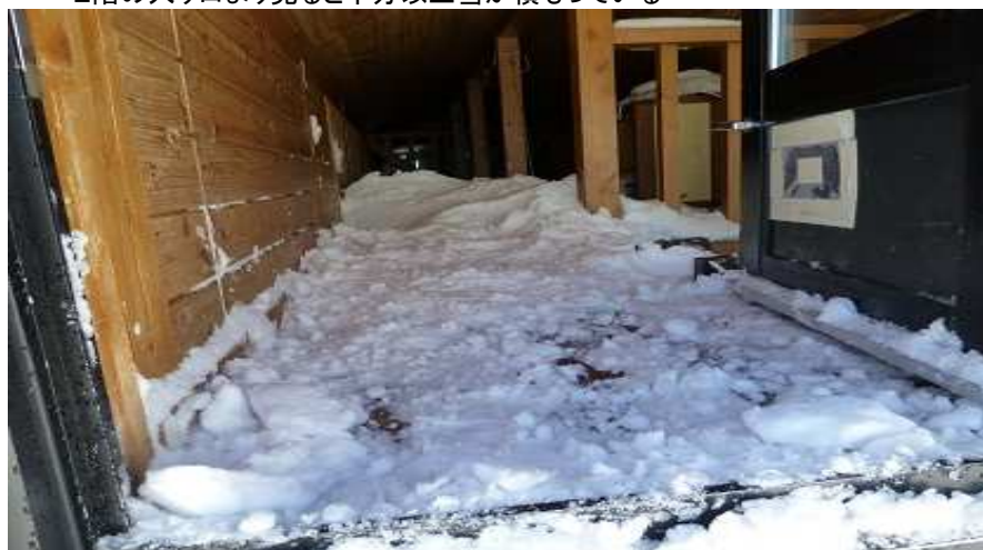
作業後(まだ雪が残っている)
