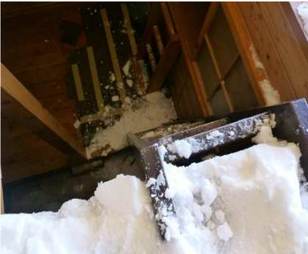
2階と1階の階段の部分
