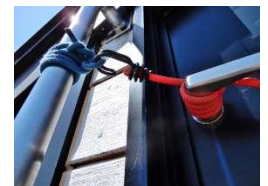
扉手にゴムバンドを取り付け手摺にフックを掛けるようにした (材料は広野氏提供)
