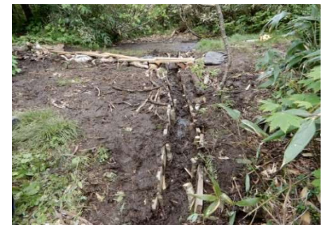
完成した水切り
