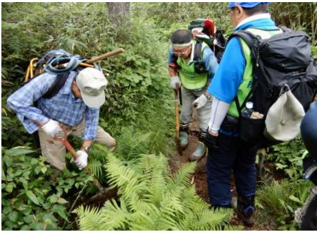
【⑥地点】水切り補修
