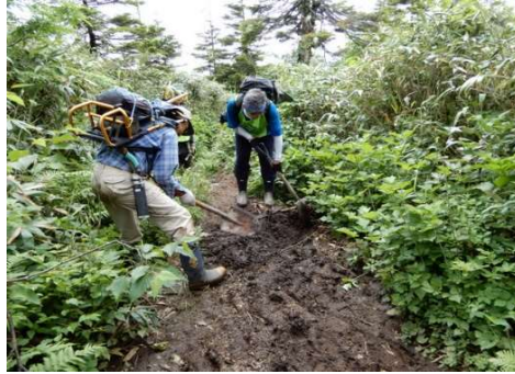
【⑦地点】水切り補修
