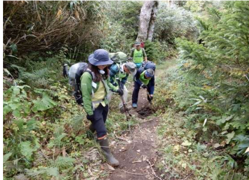
【p 地点】水切り設置
