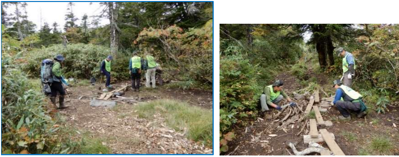
【a 地点】木歩道補修
