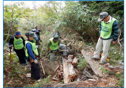
【b 地点】踏段設置
