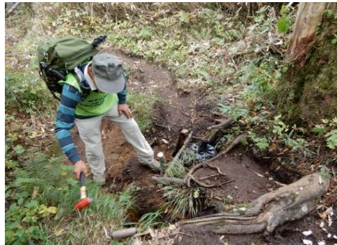
【d 地点】踏段設置
