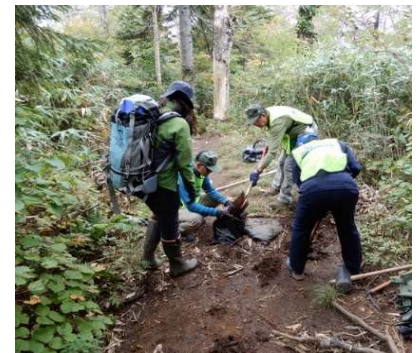
【e 地点】水切り補修
