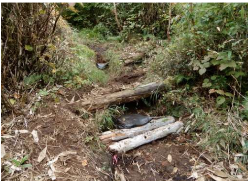
【f 地点】踏段設置
