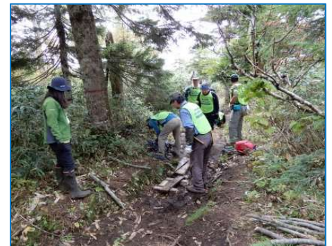
【k 地点】木歩道設置
