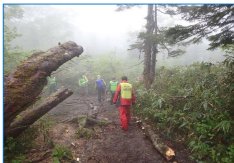
処理完了後（大松倉山方向から）
