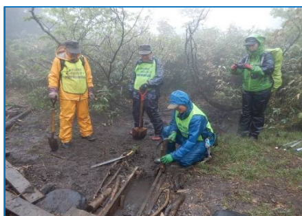
倒木1の場所、以前に設置した水切りが効果を發揮して、泥濘状態が解消していたが、さらに補修した
