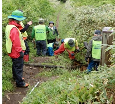
板材と土のう、木杭利用
