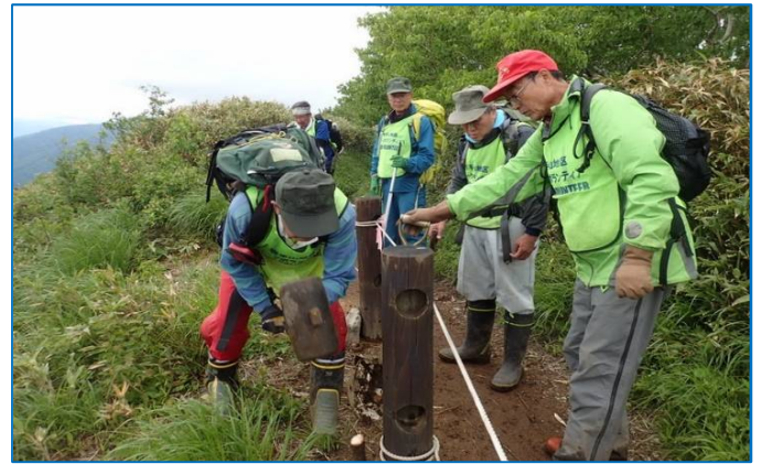
犬倉展望台の木柵支柱の根固め
