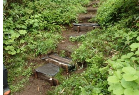
土のうと板材、杭を使用して補修
