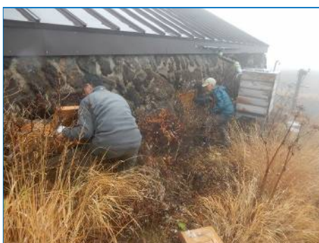
東側窓の覆戸取付
