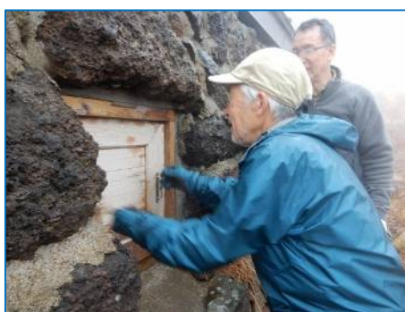
西側窓の覆戸取付
