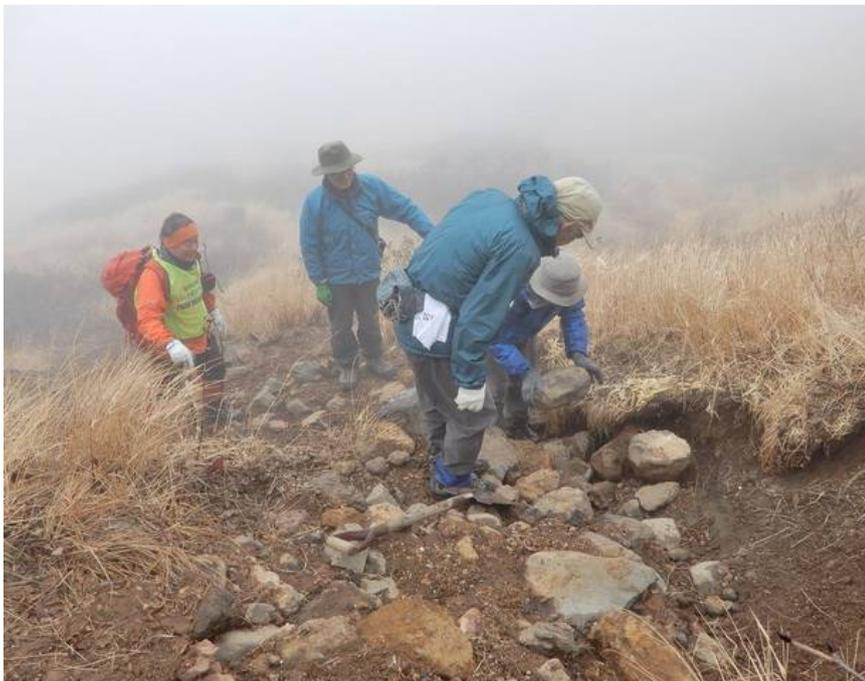
〈登山道補修作業状況〉洗掘による浮石が多く不安定なため、土止め石積を実施
