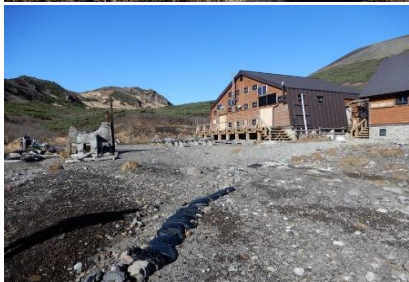
八合目小屋 前日に小屋閉め完了
