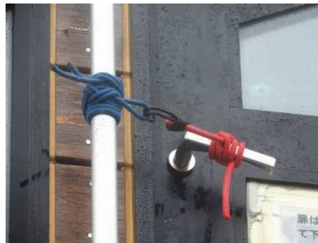
同左出入口扉の閉め忘れ防止用バンド (広野氏提供)
