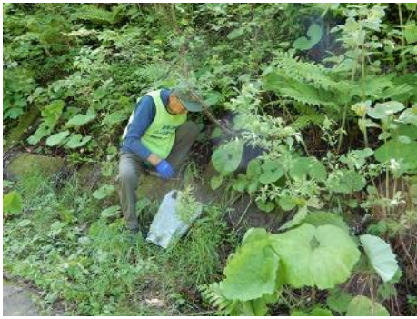
工事終点付近
