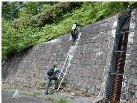
高い擁壁天端には登らず、梯子で作業。車両利用で梯子運搬が可能になった
