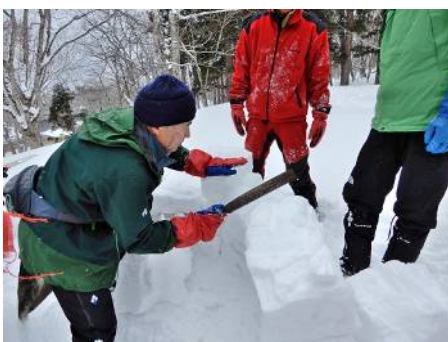
イグルーづくりは雪ブロックの整形が大事・・・ブロックにテーパを付け、接合部を平滑に仕上げる
