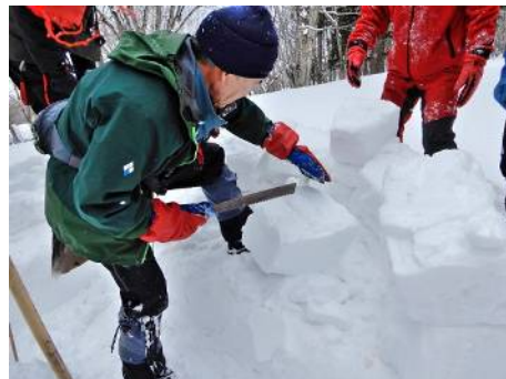
イグルーづくりは雪ブロックの整形が大事・・・ブロックにテーパを付け、接合部を平滑に仕上げる
