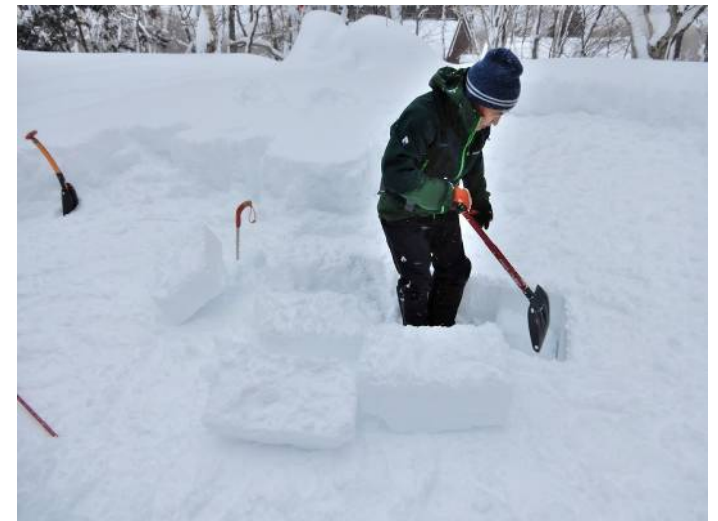
④ ブロックの切り出し (スノーソーで切れ目を入れてスコップで起こす)
