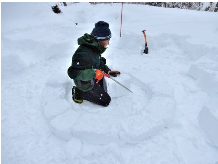
⑤ イグルーの1段目を並べる (スノーソーでブロックを整形しながら)
