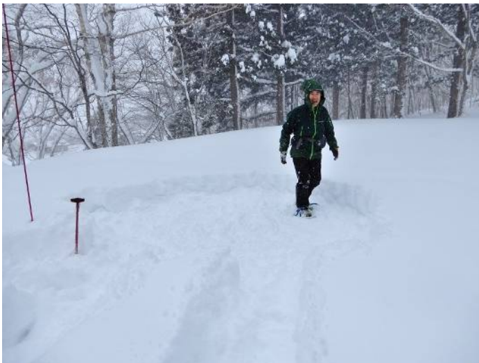
① 基盤部の踏み固め (予定イグルー外周幅約1m: 全体直径約3m)
