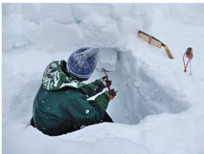
⑬ 出入口を付ける 基盤面から約0.6m掘り下げて横穴を開ける
