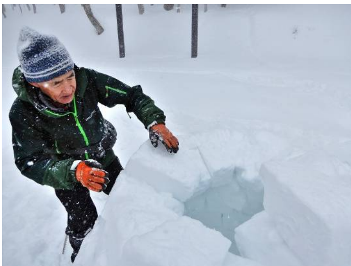
⑨ 天井部分の作業 (ブロックは中心に向かって傾斜)
