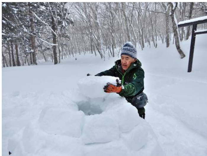
⑪ 天井ブロックを載せる (積み始めてから約1時間余)
