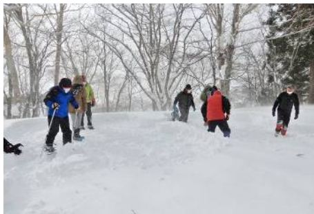
雪ブロック切り出し予定範囲と、イグルーを作る場所を全員で踏み固めた 踏み固め後、15分程度で雪がしっかり固結する
