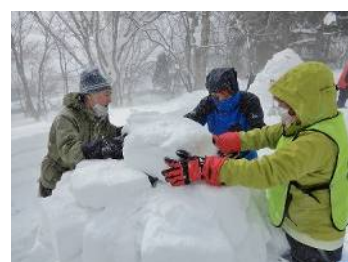
ブロック積みの終盤、天井部を絞るのに注意を要する
