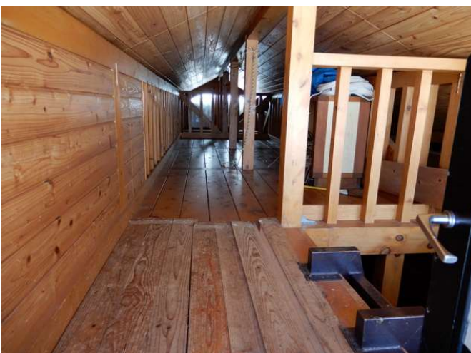
小屋内上部(2階部分)の状況 吹き込んでいた雪氷を以前に民部田、広野両氏が除排雪してくれたので、床は乾きあがり綺麗であった
