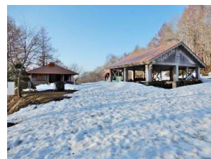
東屋とトイレ棟 鬼又清水は湧出中、トイレは閉鎖中
