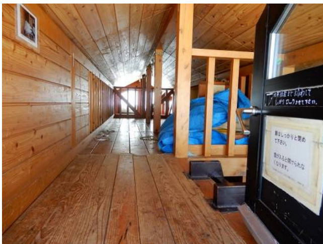
二階部分は雪の吹き込みも無く乾燥している
