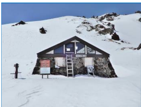
北側:異常なし
