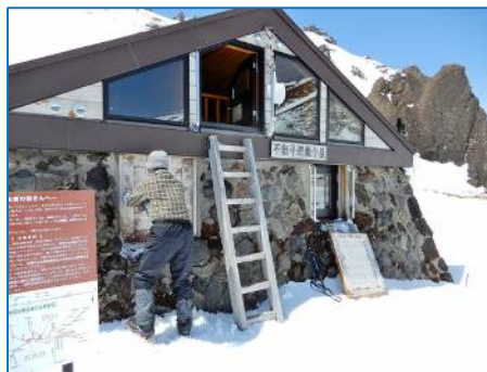
トイレ窓と冬期出入口窓の覆板撤去
