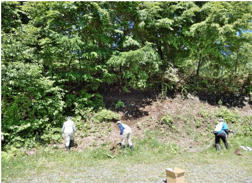
作業開始時の法面状況
