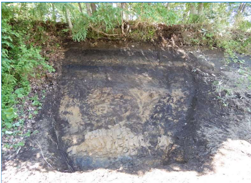
作業終了し地層が見易くなった法面
