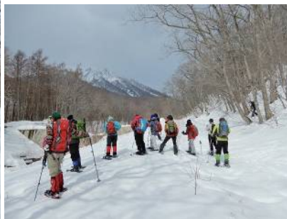
熊沢砂防ダム付近
