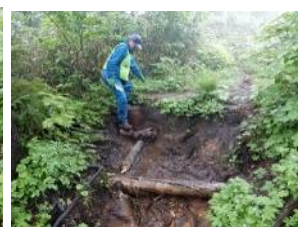
泥濘箇所にも風倒木を利用して足場を設置
