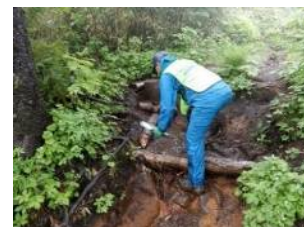
泥濘箇所にも風倒木を利用して足場を設置
