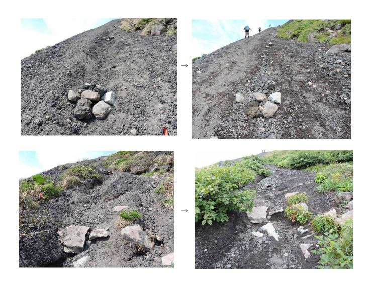
2. 2019 年 8 月 22 日に土嚢を積んで水切りした箇所の直上(通常ルート) 左は 2021 年 6 月 17 日 大きな浸食が見られたので広野が応急的に近くの石を積んだ写真 右は 8 月 24 日の写真 積んだ石は動かず、溝に砂礫が堆積している。
