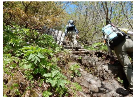
木造階段(標高約1,520m付近)
