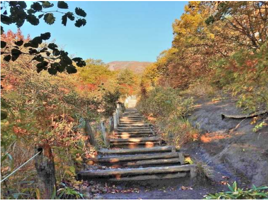
1合目上の古称「大ナメリ」の木造階段等 (H≒930m) 1997(H9)年頃整備 (2016/10/15撮影)
