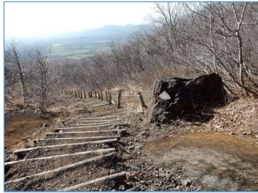
「大ナメリ」上部の豆腐岩付近 (2016/04/24撮影)
