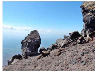
御蔵石の崩壊 (2016/05/15撮影) 2008(H20)年7月下旬から8月初旬の間に崩壊。その後も部分剥離
