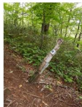
倒れ掛かった誘導標柱 表示内容読み取り不可 (H 910m付近)
