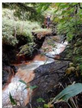
木橋(丸太橋)(H1,130m付近)、桁下は約2.5m以上?、ウォーターライダー状の岩盤 丸太2~3本の主桁は腐朽が進んでいる。 早急に架替必要
