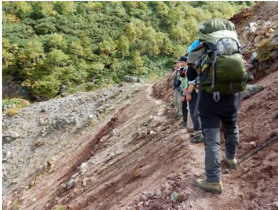
滑落危険箇所 (DSCN7943)
