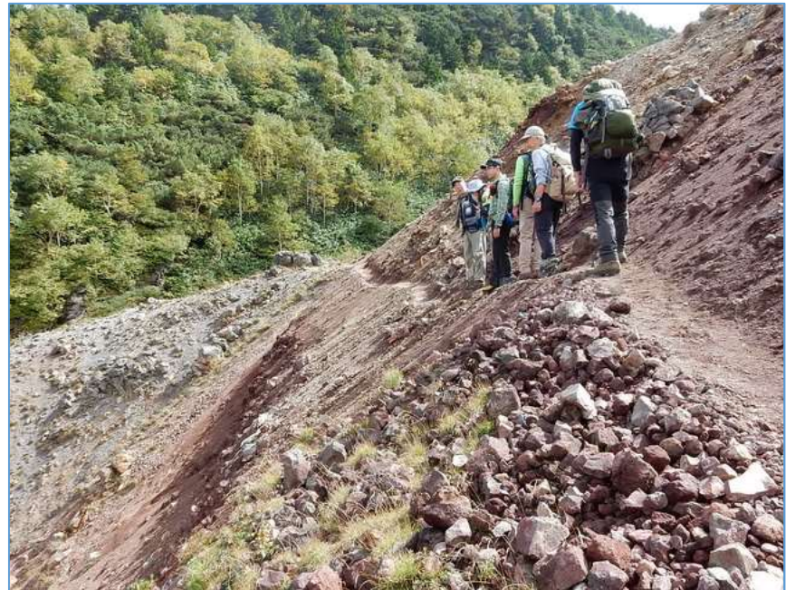
路幅狭小、左側は沢底まで急斜面崩落地
