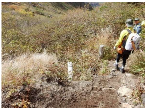
旧道通行止柵が倒壊 (H1,800m付近)
