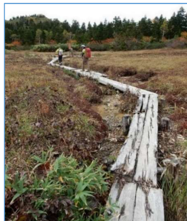
木歩道腐朽(要補修)
