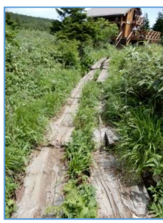
三ツ石湿原の木歩道は腐朽が進んでいる (小屋から山頂方向) 利用者の転倒事故防止のためにも早期改修が望まれる
