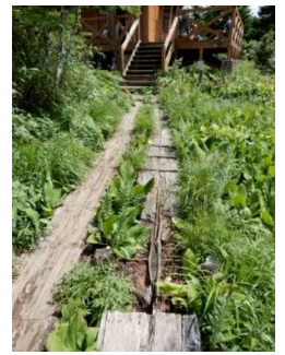
三ツ石湿原の木歩道は腐朽が進んでいる (小屋から山頂方向) 利用者の転倒事故防止のためにも早期改修が望まれる
