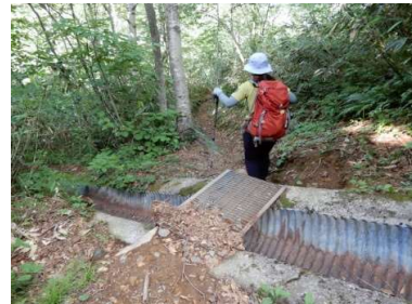
木階段途中のコルゲート半割管水路
