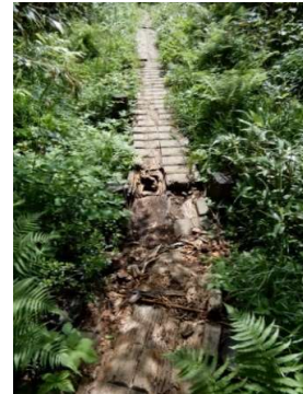
小屋から水場方向の木道も部分的に腐朽が著しい
