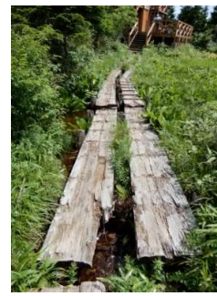
三ツ石湿原の木歩道は腐朽が進んでいる (小屋から山頂方向) 利用者の転倒事故防止のためにも早期改修が望まれる
