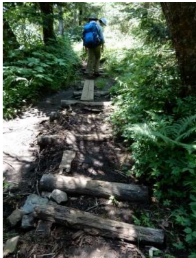
同、約435m付近
