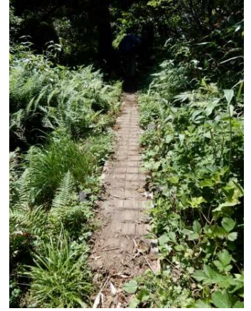
同、約115m付近
