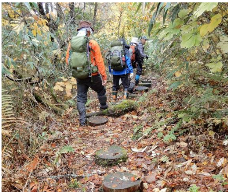
湿地区間には輪切り丸太が敷かれているが、滑り易い安全確保のために滑り止めなどの工夫が必要
