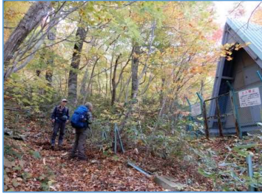
標高750m付近、御所ダム雨量観測施設
