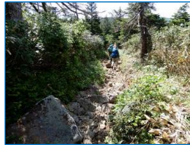
洗掘され河原状になった登山道 石沼手前約400m付近
