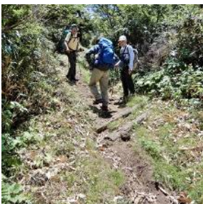
機能不全の水切り 大深山荘手前約300m付近 この前後に数ヶ所同様の水切りあり
