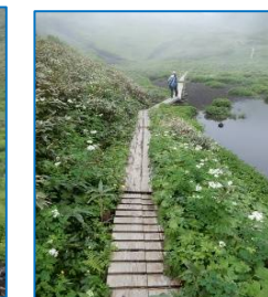
(No.23) 横溝加工木道終点 無加工木道起点
