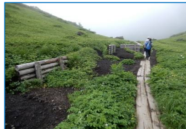
(No.19) 土留柵3基
