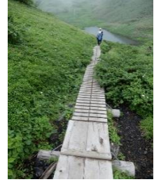
(No.21) 栈木打ちから 横溝加工木道
