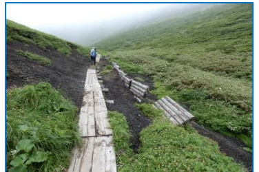
(No.16) 土留柵7基
