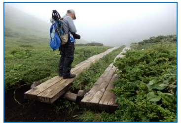
(No.9) 木道起点 (ダブル)
