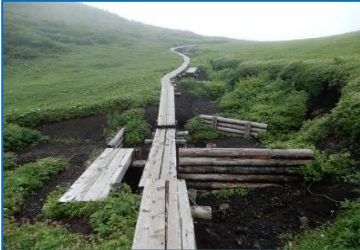
(No.11) ベンチと土留柵2基
