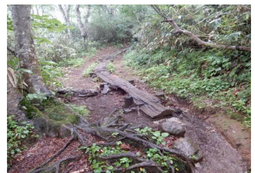
(No.15) 木道腐朽だが歩行に支障なし
