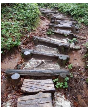
(No.12) 木段の間詰 しっかり手入れされている
