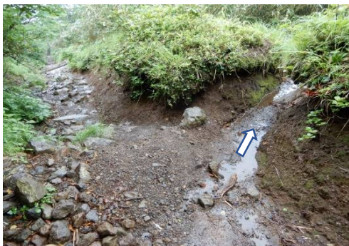
(No.24) 水切り 登山道側壁を切欠き排水
