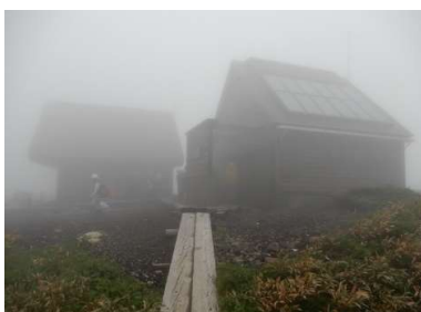
阿弥陀池避難小屋と公衆トイレ
