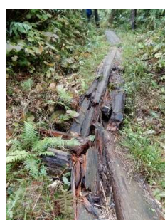
湿原上部の木歩道も腐朽著しく滑る
