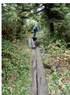
湿原上部の木歩道も腐朽著しく滑る
