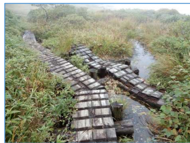
腐って折れた木道 左の分岐から千沼ヶ原方向約100m
