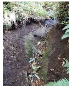
(No.71) 深掘れ箇所
