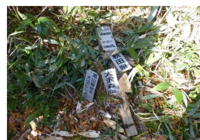
大沢森 標柱倒壊 「大沢森1178m」 「秋田県」 「←大白森山荘2.5km」 「曲崎山2.0km →」
