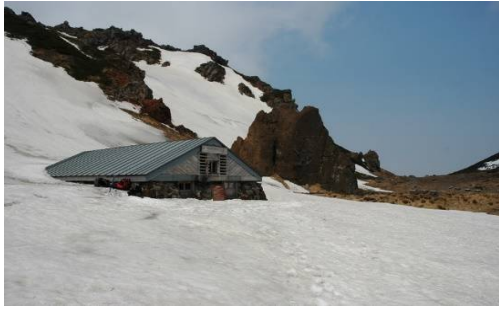
2005(H17)/05/04 <2代目小屋> (改築工事6月着手、10月末完成)
